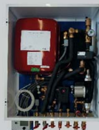
Тепловой пункт с независимым подключением системы отопления квартиры к отопительной магистрали (через теплообменник)
