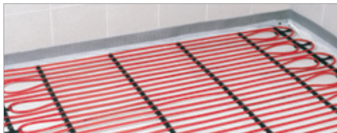
Система напольного отопления/охлаждения («мокрый» способ укладки труб)
