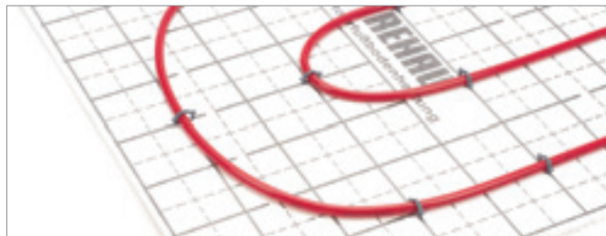
Крепление труб с помощью гарпун-скоб
